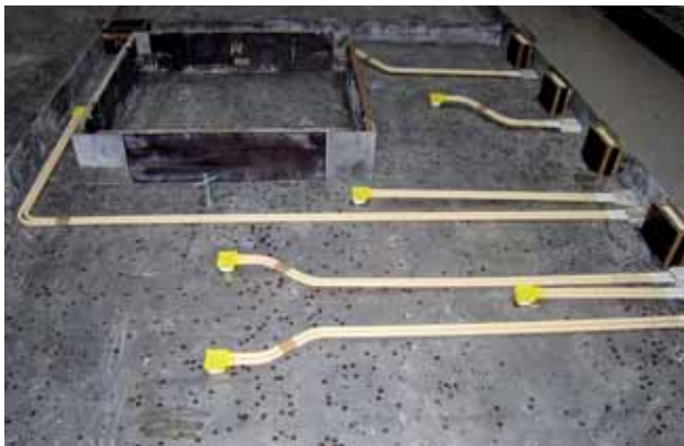
Figur 23. El-indstøbninger lagt op i støbeformen til betonelement. Bemærk at rørføringen er tilpasset de udspæringer, som ligger i bunden af elementet (billedets højre side). Rørføring skal generelt forløbe lodret i elementet. I dette element har vandret rørføring til lampeudtaget over vinduet imidlertid været eneste mulige løsning. Elementet dobbeltarmeres og el-rørene fastbindes til armeringsnettet.
