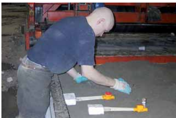
Figur 33. Ilægning af el i opsiden af et letklinkerbetonelement.
