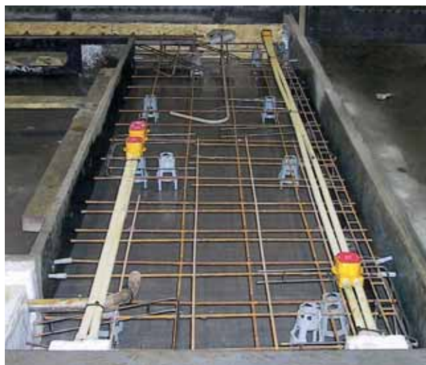
Figur 26. El-indstøbning i opsidens af et betonelement. De el-rør og dåser, som skal ligge i opsidens af et betonelement, ilægges oftest inden udstøbning. Indstøbningsdelene opløses på armeringen og fastholdes hertil. Elementet er set nedefra. I det færdige byggeri sker kabel-/rørføring i gulvet.
