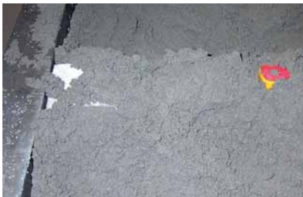
Figur 34. Letklinkerbetonelement under produktion. Forhøjning med indbygget FUGA 1M dåse, rør og udsparring. Efterfølgende udlægges den resterende letklinkerbeton, som afrettes og komprimeres.
