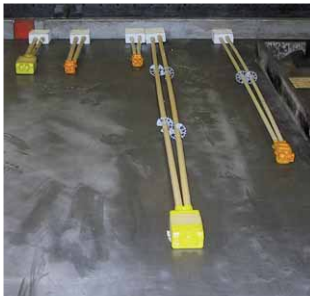
Figur 22. Støbebord til et letklinkerbetonelement. I for-siden er anbragt FUGA indstøbningsdåser og dåser til flerpoledede stikkontakter. De længste rør er forsynet med afstandsholdere, (»citron-skiver«), der sikrer fuld omstøbning af rørene.
