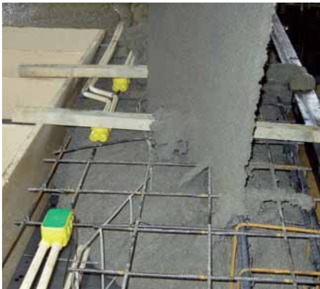
Figur 30. Udstøbning af beton. Her er flere dåser i opsiden fastholdt v.h.a. lægter. Når elementoverfladen senere skal viderebehandles, f. eks. gliettes, skal lægterne fjernes.
