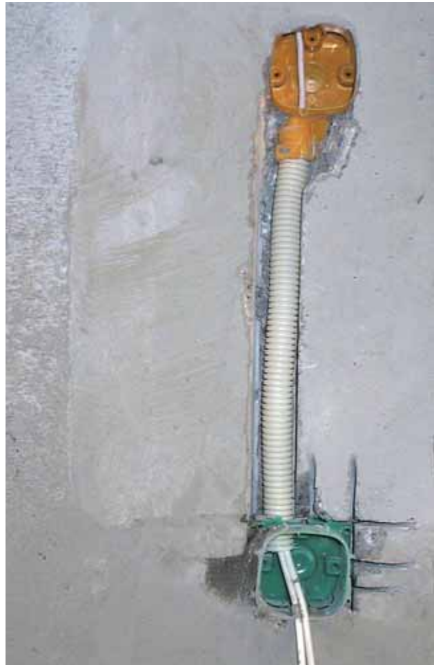
Figur 41. Udbedring af fejlplaceret dåse.
